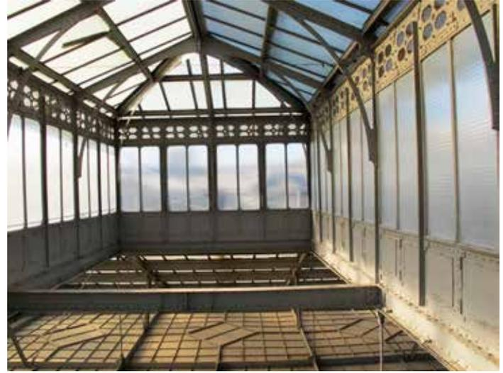
que garantizan la estanqueidad del conjunto. Los vidrios van solapados formando calles escalonadas. Entre los solapes y en las limas existen baberos de plomo.
