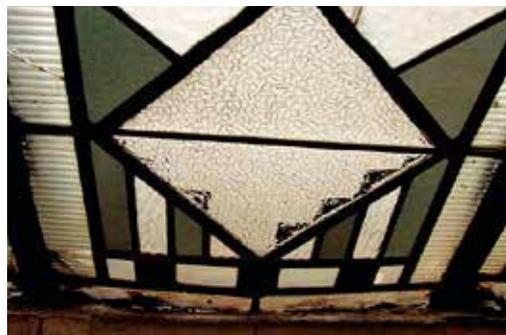
Fig. 84 Panel del nivel 1 antes de la intervención. La greca escalonada original había sido sustituida por otra pintada en frío, con un resultado muy deficiente
