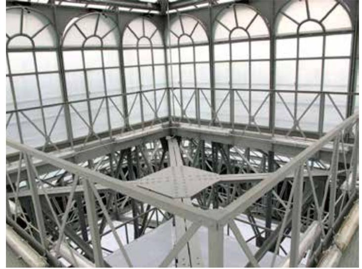
semicirculares abatibles de eje horizontal. Se procedió a establecer un sistema de automatizado con motorización eléctrica que permite el manejo de apertura y cierre a distancia [figs. 70 y 71].
