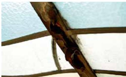
Fig. 77 Perfil metálico dañado por el impacto de la metralla
