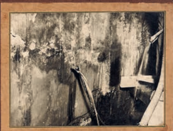
Puentes de drenaje del terreno en el Pozo número 1 para descargar la presión.
