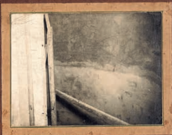
Taponamiento en el Pozo nº 1. Tercera etapa del trabajo de impermeabilización. Revoque final con antihidro "WATFON".
