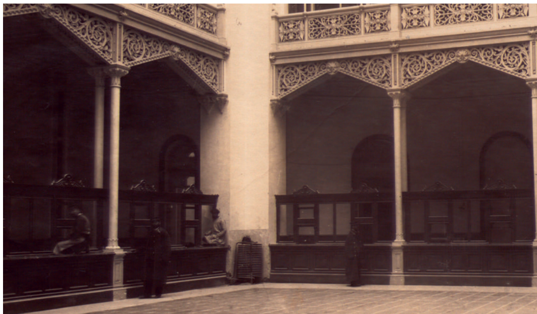
Detail of a photograph by J. Laurent y Cía. of the Cash Till Court at Banco de España, showing heating pipe coil. Archivo Histórico del Banco de España, Colección de Fotografías (no. inv. 6391)
